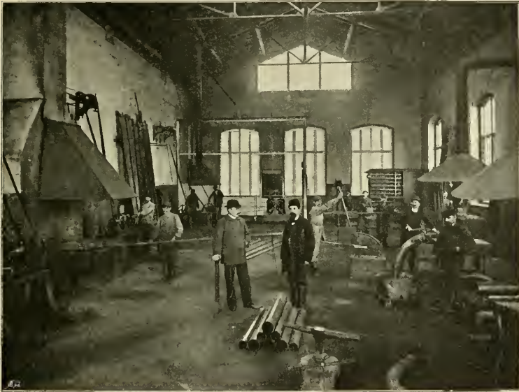
Abb. 381. Werkstätte Neu-Sandec der k. k. Oesterreichischen Staatsbahnen. [Rohr- und Kupferschmiede.]
